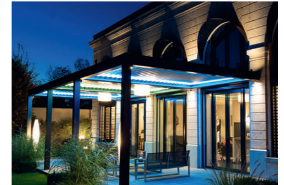
Éclairage strip leds
