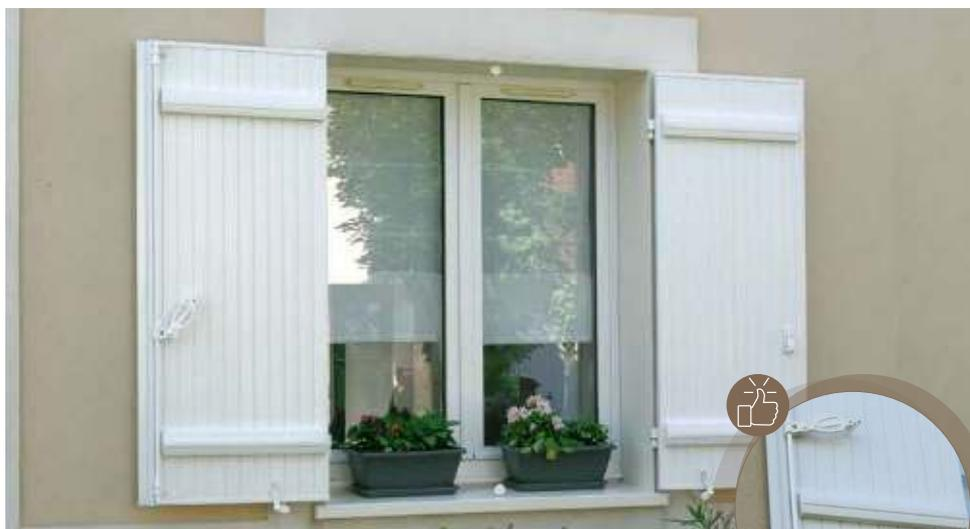
La commande déportée permet la manipulation du volet sans se pencher.
