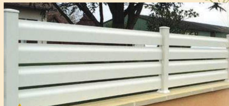
▲ Lames brises-vues alu horizontales à entraxe de 160 mm
